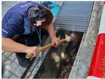
ภาพที่ 3-1 การดูแล บำรุงทำความสะอาดรางระบายน้ำ
